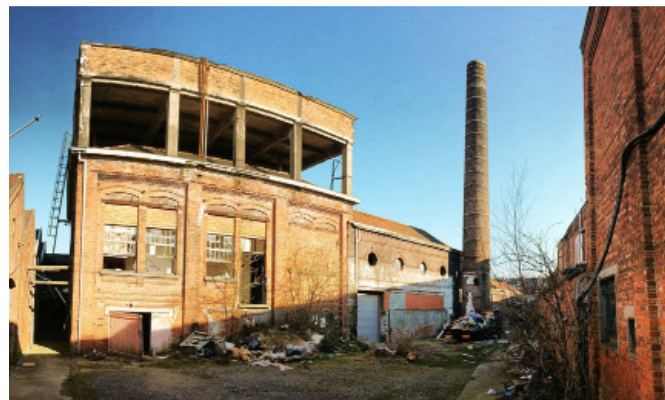
MACHINEGEBOUW MET WATERBAK EN SCHOUW
