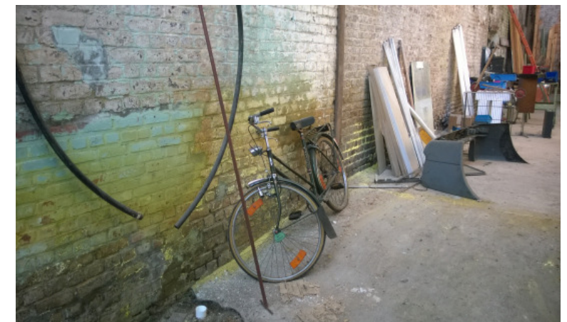
Verontreiniging met zware metalen; opstijgend verontreinigd grondwater doorheen bakstenen muren; kristallisatie van verontreiniging
